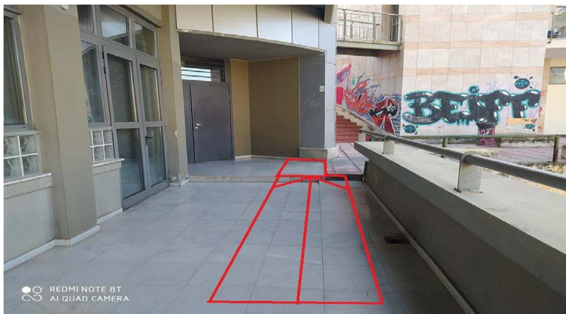
Φωτογραφία 7 : Θέση ράμπας στο κτήριο E13 των Χημικών Μηχανικών.
